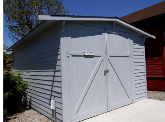
车库地址: 4651 Kingswell Ave, Los Angeles, California
